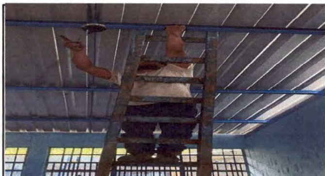
Foto 9. Reparación de sistema eléctrico (sustitución de lámparas, plafoneras, interruptores, tomacorrientes y cableado eléctrico).
