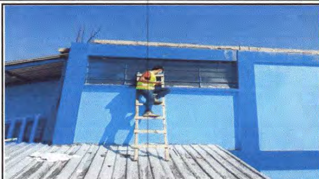
Foto 2: Mantenimiento a ventanas y sustitución de vidrios.
