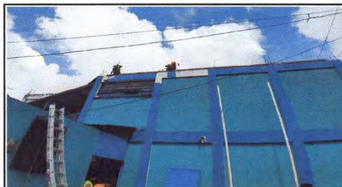
Foto 3: Pintura en muros interiores y exteriores
