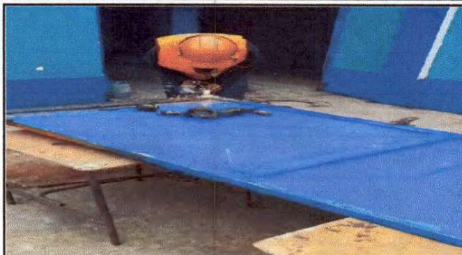
Foto 8. Mantenimiento a portones de metal.
