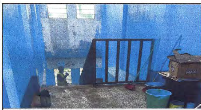
Foto 5: Mantenimiento a barandas de metal.
