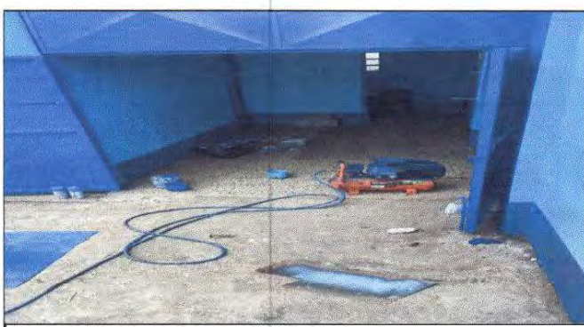
Foto 6: Mantenimiento a portones de metal.
